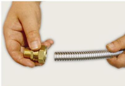
3. Обжимаем фитинг гаечным ключом
