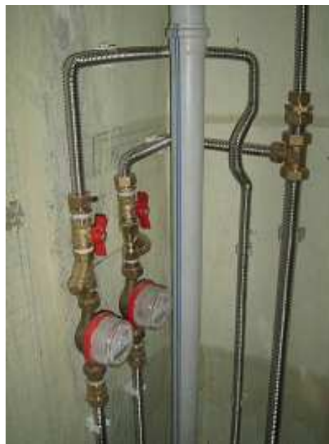
обвязка стояков и подвод газа к котлу
