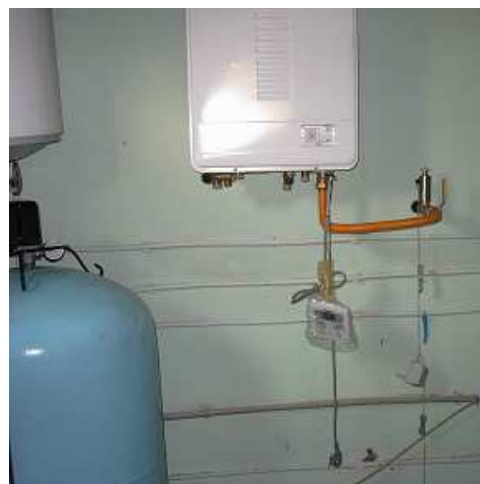
обвязка стояков и подвод газа к котлу
